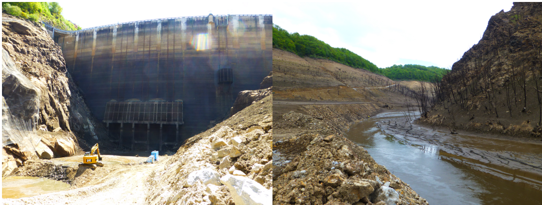
Figure : Vidange du barrage de Sarrans (crédits: M. Jodeau).
